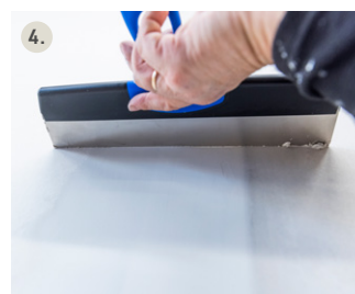
4. Ferdig skjøtsparkling. Forsenkningen er slett, uten å bygge ut.
