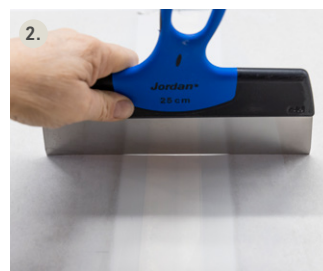
2. Forsenkningen skal foreløpig ikke være fylt med sparkel. Det gjøres i neste trinn.
