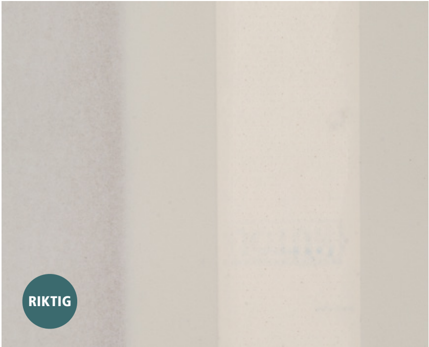
Korrekt utført innsparkling av sparkelremse. Sparkelremsen er presset godt inn mot gipsplaten i skjøtforsenkningen.
